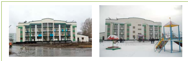
1. Барнаул. Энергоэффективный дом
