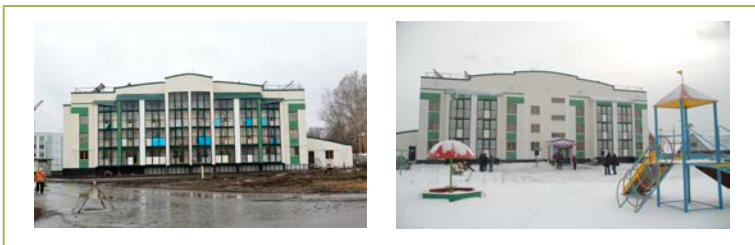
1. Барнаул. Энергоэффективный дом
